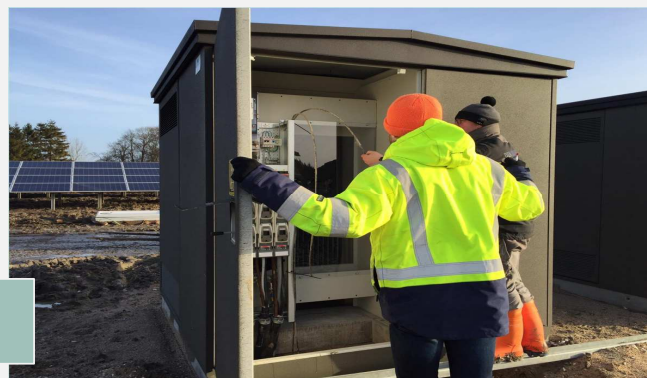
Tekniker installerer transformer
